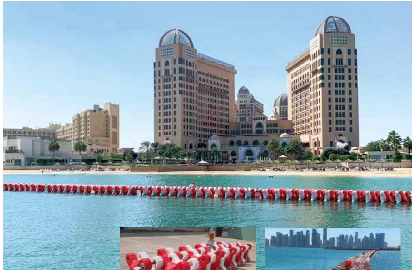
QATAR BREAKWATER 卡塔尔防波堤 长度 Length:180m 年份 year:2019 ▶
