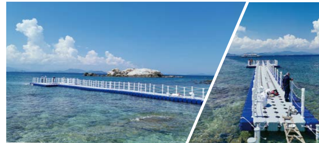
海南三亚浮桥 HAINAN, CHINA
